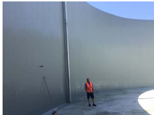
Stav po dokončení
