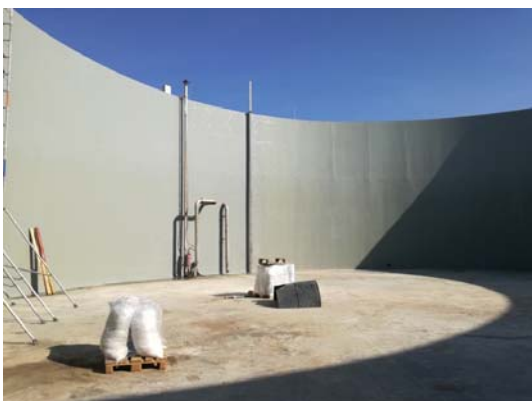
Stav po dokončení
