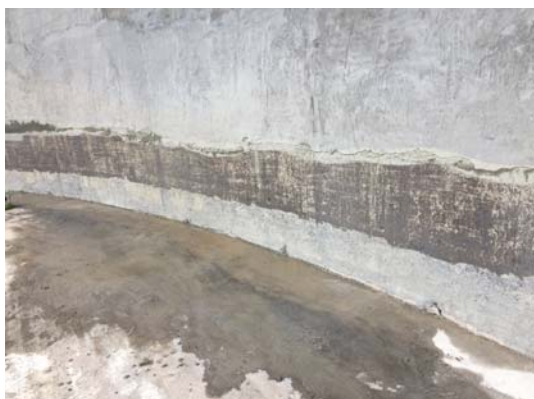
Podklad po otryskání VVP a lokální reprofilaci
