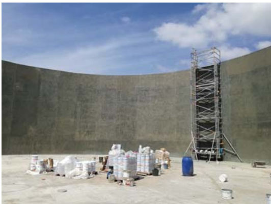
Vystěrkováný a uzavřený podklad zasypaný speciálním pískem
