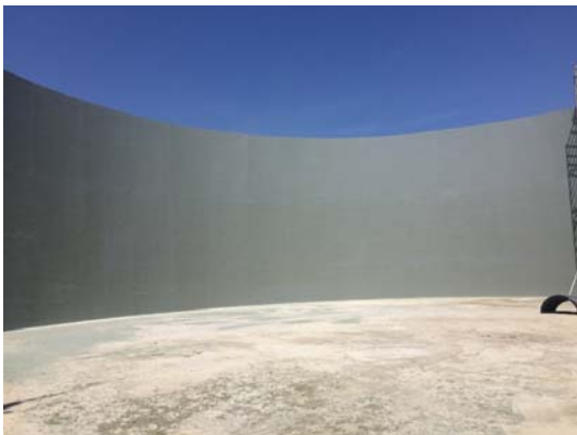
Stav po dokončení
