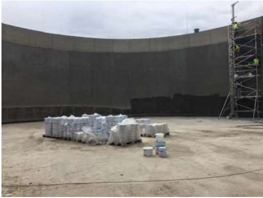
Skladování materiálu, nanášení penetrace
